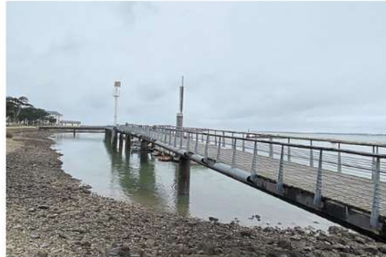
L'estacade du Croisic est gérée par le Département. Mais son entretien a un coût.
